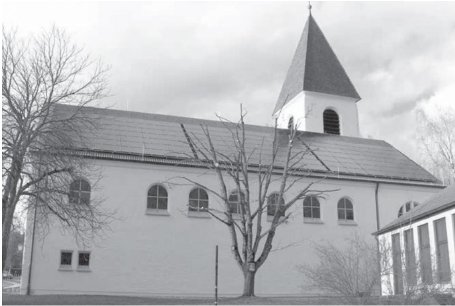
Schwarzenbruck im Bistum Eichstätt produziert mit Hilfe von 156 Solarmodulen weit mehr Strom und Wärme als die Kirche verbrauchen kann.
