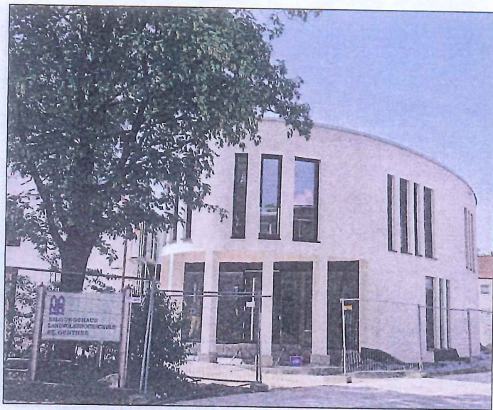
Der elliptische Anbau der LVHS, die „Ideenschmiede“, ist fertig.
